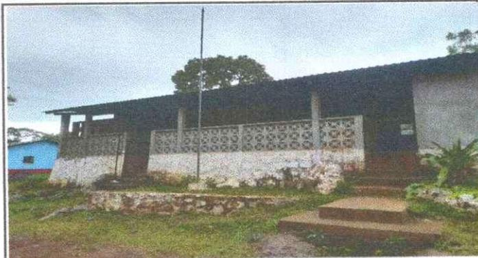
Foto 2: Mejoramiento de establecimiento, se incorporara 4 hiladas de block de altura, se ampliaran las columnas y se haran las soleras correspondientes de concretos en vez de costaneras.
